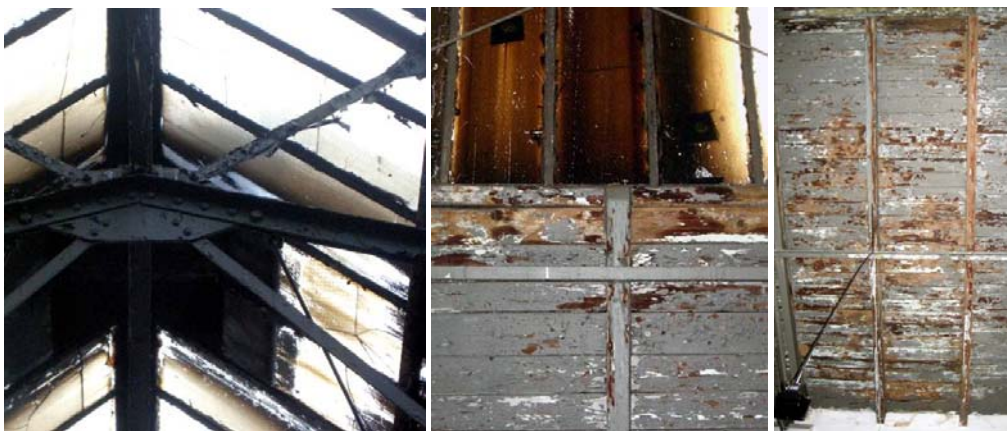
Fot. 2. Stan elementów konstrukcji dachu i pokrycia, M. Górski.
