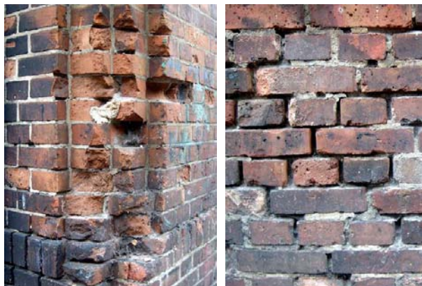
Fot. 4. Ubytki cegieł i zaprawy w zewnętrznych ścianach nośnych, M. Górski.
