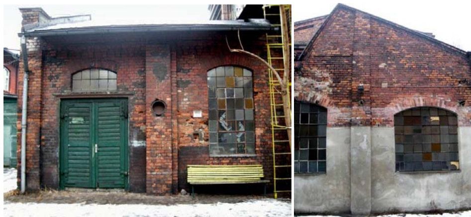
Fot. 1. Widok ogólny budynku Stolarni Fabryki Drutu – elewacja południowo-wschodnia i południowo-zachodnia, M Górski.
