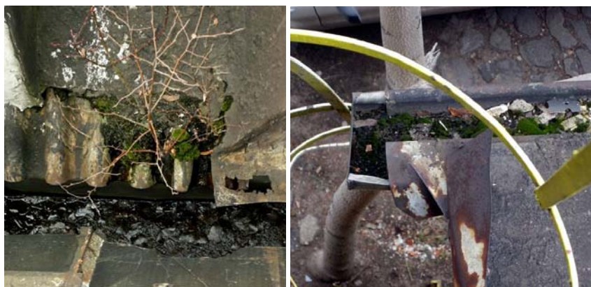
Fot. 3. Niedrożne systemy odwodnienia dachu, M. Górski.
