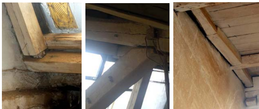
Fot. 2. Stan techniczny elementów konstrukcji dachu i połączeń ciesielskich, M. Górski.
