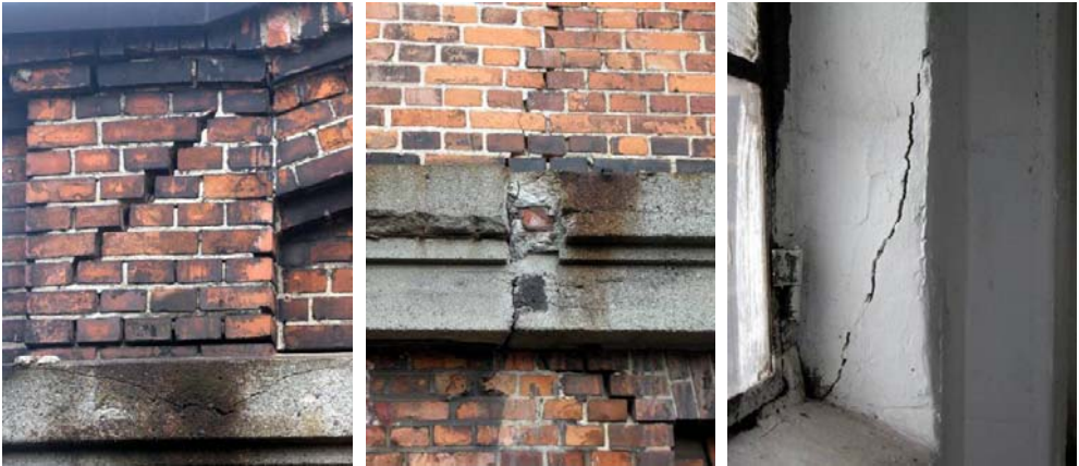
Fot. 3. Stwierdzone uszkodzenia strukturalne muru w ścianach (ściana południowo-zachodnia), M. Górski.
