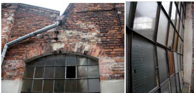
Fot. 4. Uszkodzenia spowodowane złym rozwiązaniem podparcia podciągu, M. Górski.
